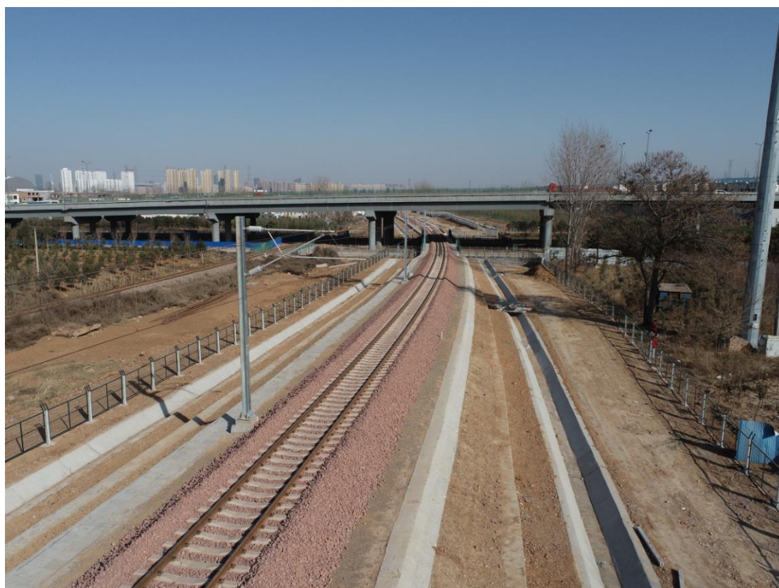
新建线路区两侧的排水沟
