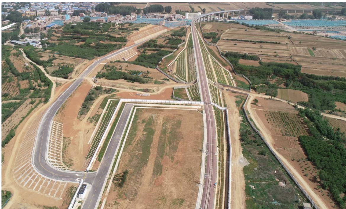
2021年5月存车场道路完成情况
