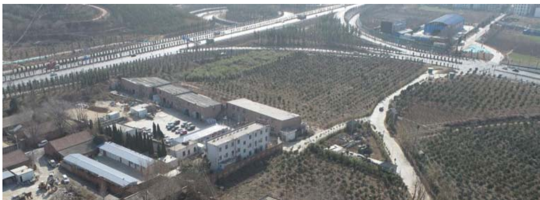
项目部航拍图
