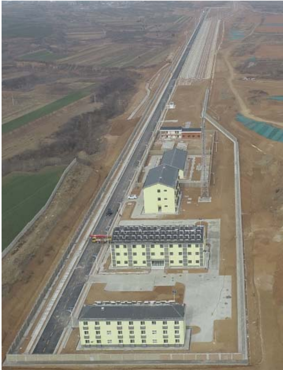
存车场航拍图（1月）
