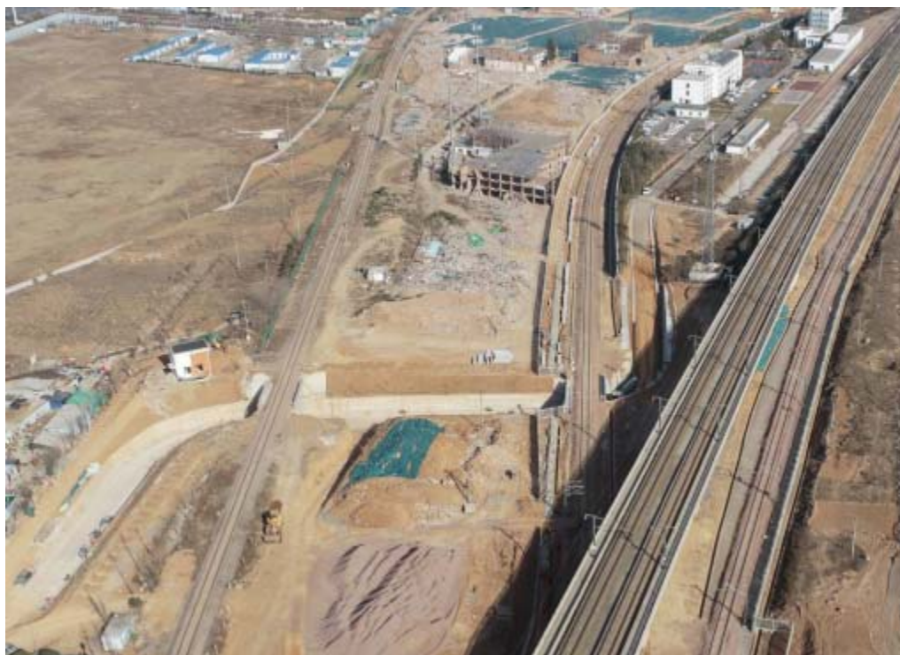
通维修工区道路及维修工区航拍图
