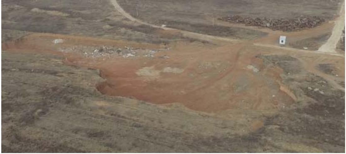
1#取土场现状情况（1月）
