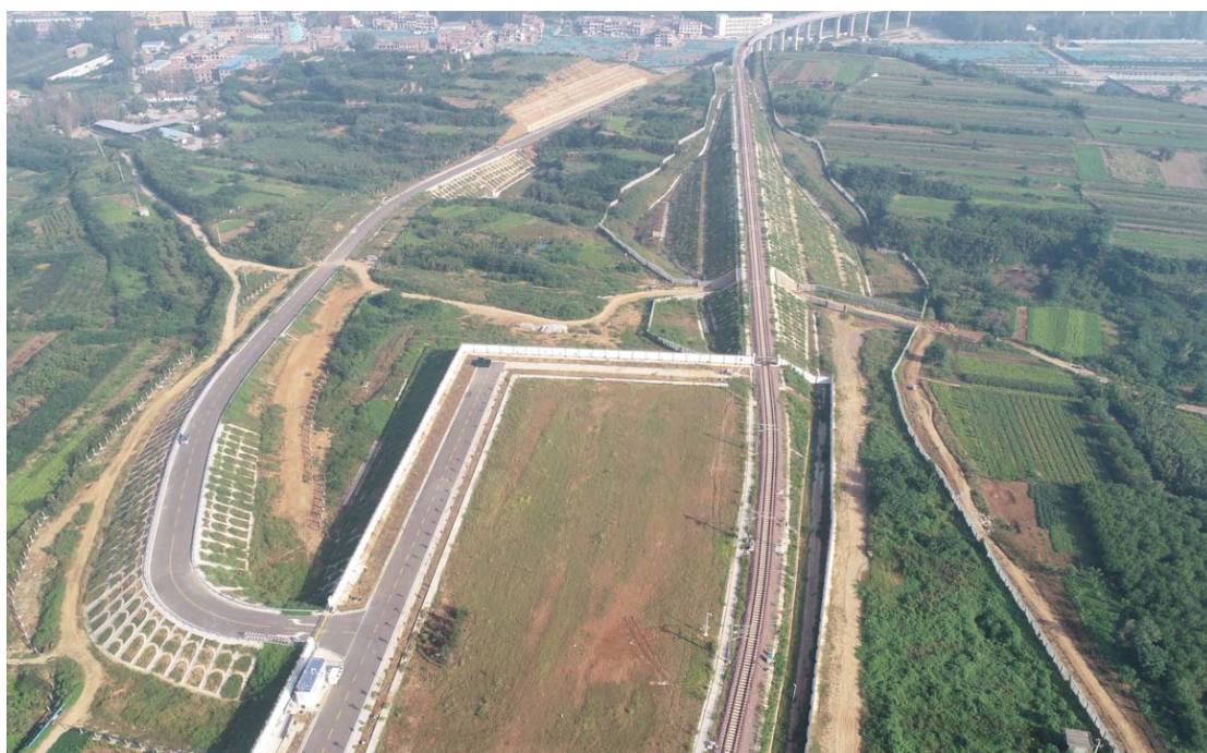
2021年7月存车场道路完成情况
