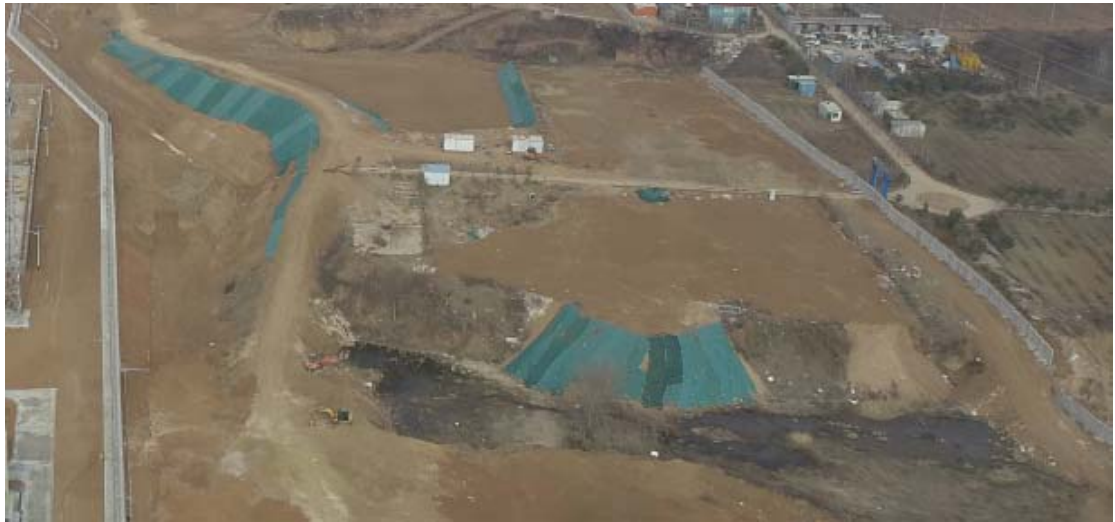
改移沟渠及3#取土场区（1月）
