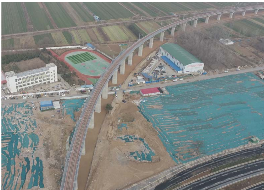
小李屯大桥及钢筋加工场区（1月）
