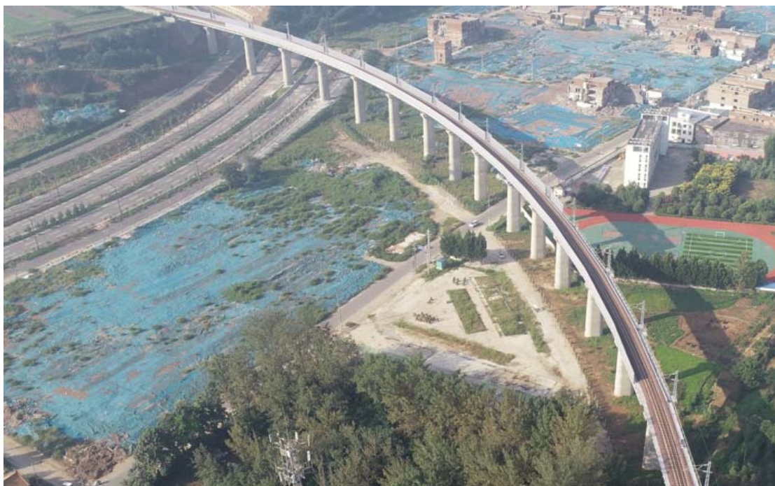
小李屯大桥及钢筋加工场区（9月）
