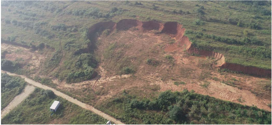
1#取土场现状情况（9月）
