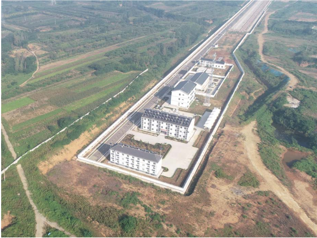
存车场航拍图（9月）
