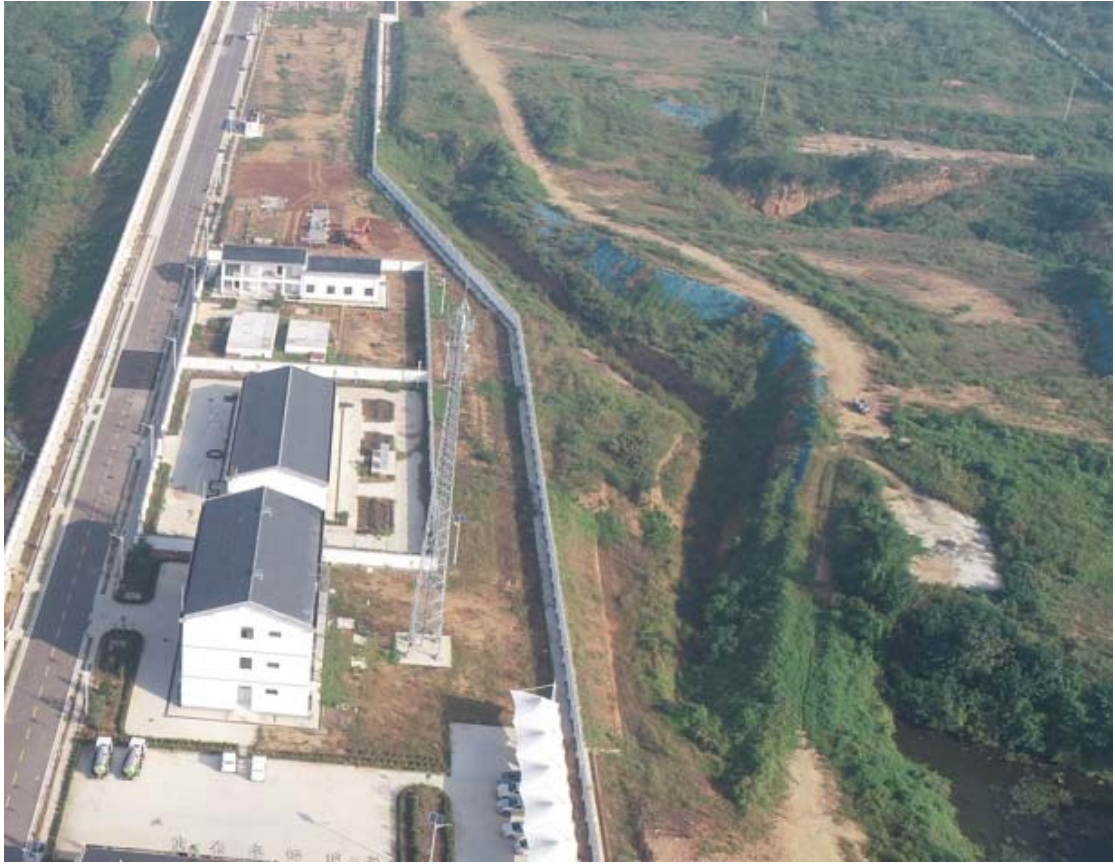
改移沟渠及 3#取土场区（9 月）
