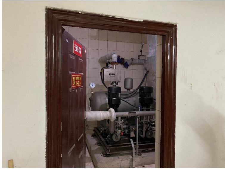
图 7.3 地下泵房现场照片
