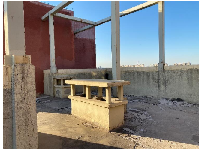
图 7.11 楼顶炊事油烟排气筒
