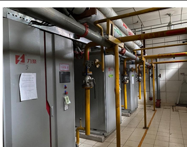
图 7.4 地下锅炉房现场照片
