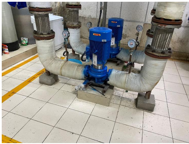
图 7.7 锅炉房减震基础和软连接
