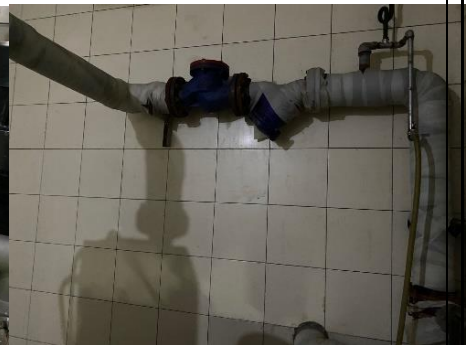
图 7.6 泵房减震基础和软连接
