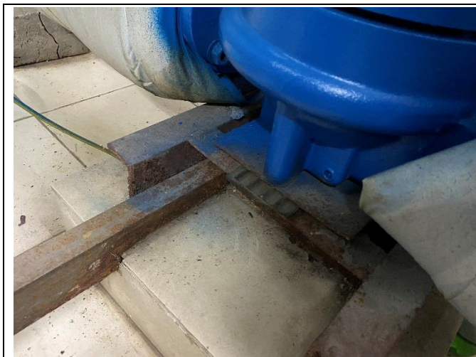
图 7.6 泵房减震基础和软连接
