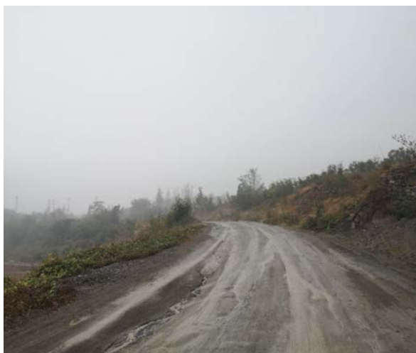
I标1队便道已重新硬化，作为维修通道、 地方道路使用
