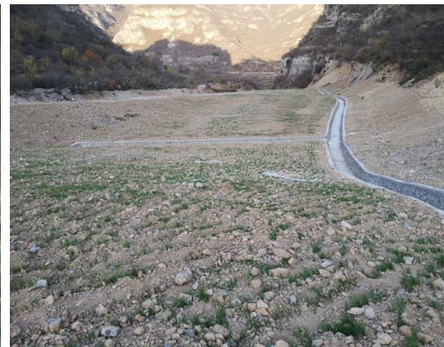
群峪2号弃渣场现场照片
