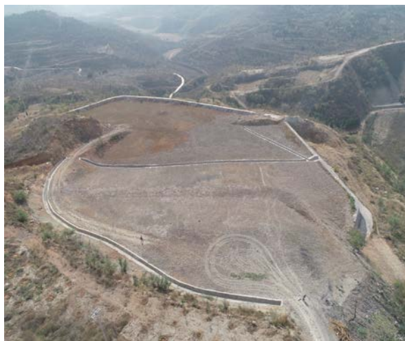
老马岭隧道弃渣场航拍图
