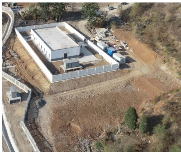
I标2队施工生活区（已绿化）
