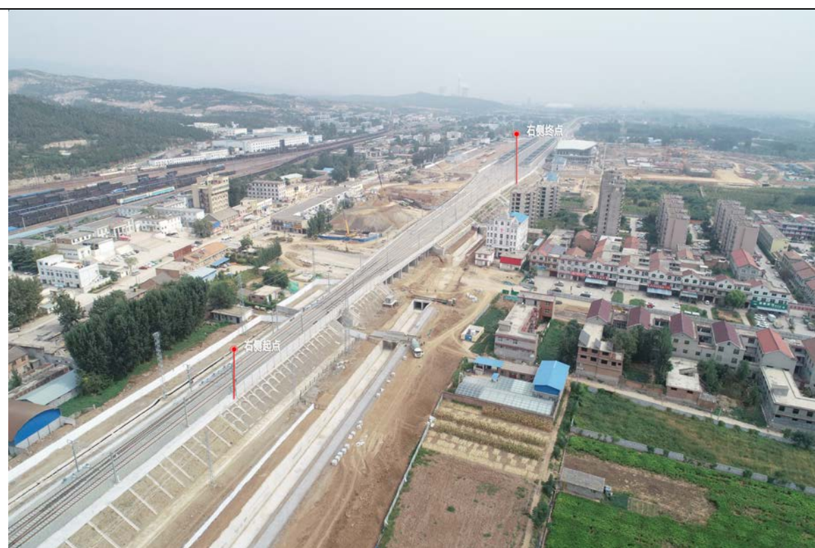
图7.2-3 棉纺厂家属楼（N96）、后桥村（Y5）
