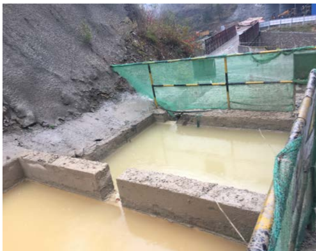
太行隧道涌水沉淀池
