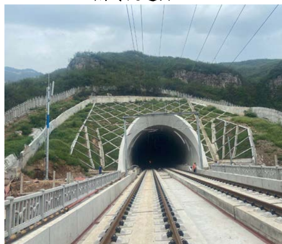
老马岭隧道出口
