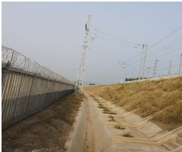
路基边坡防护（DK346+600附近）
