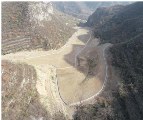
群峪2号弃渣场航拍图
