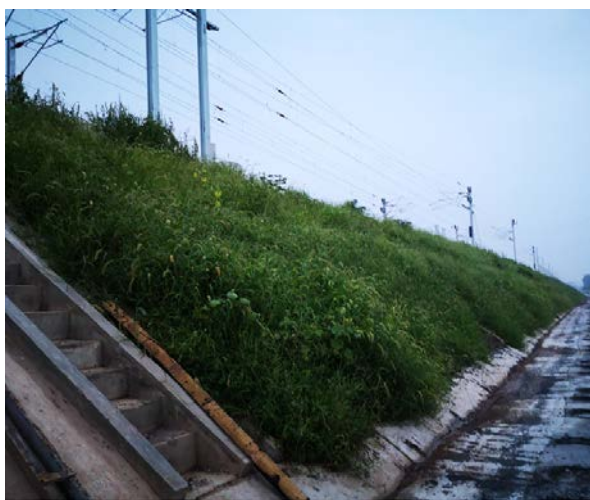
路基边坡防护（DK348+500附近）
