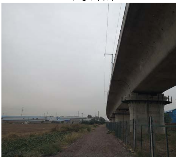
II标2分部便道作为地方道路利用
