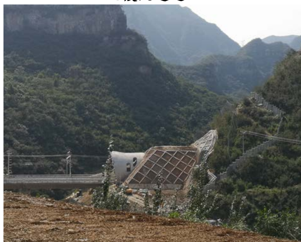
太行隧道出口
