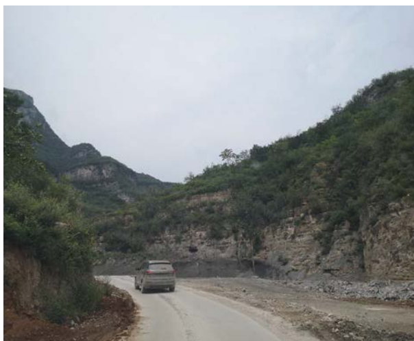
I标1队便道已重新硬化，作为维修通道、 地方道路使用
