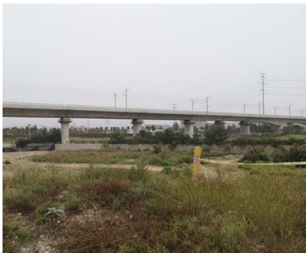
大沙河特大桥
