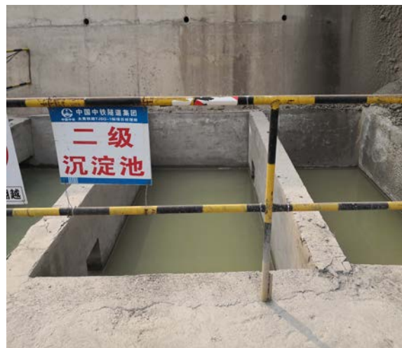
I标2号拌合站沉淀池
