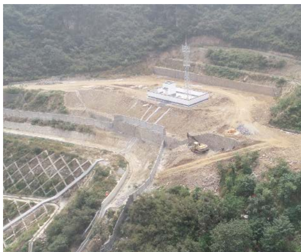
I标1队施工生活区（已绿化）
