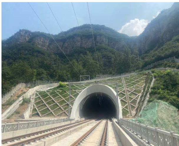
九渡隧道进口
